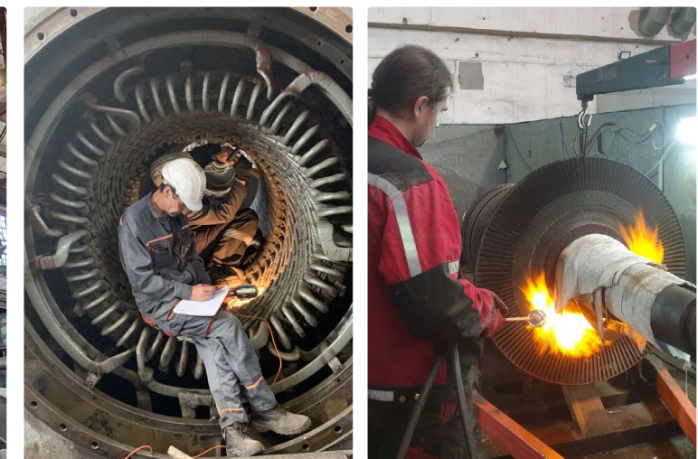
Капітальний ремонт обладнання енергоблоку ст.№4 ТЕЦ ПрАТ «Камет-Сталь», Метінвестхолдинг (турбіна АТ-25-2 ТМЗ, генератор ТГВ-25, насоси, конденсатор, підігрівачі та інше обладнання машинної зали, ремонт електродвигунів насосів та інших систем, заміна високовольтних вимикачів, ремонт іншого електричного обладнання та пристроїв КВП та А).
