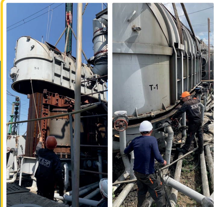
Ремонт блочного трансформатора типу ТДЦГ-400000/154 та газоходів котла енергоблоку №1 Криворізької ТЕС ДТЕК Дніпроенерго.
