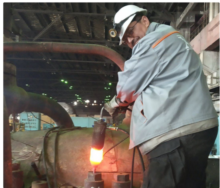
Ремонт турбіни К-200-130 енергоблоку ст. №9 та ремонт циліндра високого тиску і ремонт ротора середнього тиску із заміною пошкоджених лопаток та бандажа турбіни К-200-130 енергоблоку ст.№7 ДТЕК Бурштинська ТЕС Західенерго.
