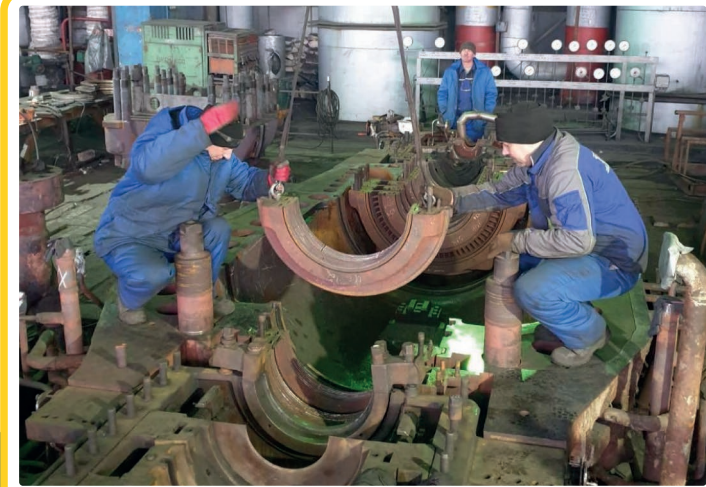
Капітальний ремонт турбіни К-300-240 Трипільської ТЕС ПАТ «Центренерго» під час та після обстрілів у зимовий час у машинному залі без вікон.
