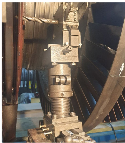
Капітальний ремонт турбіни К-200-130 ст. №5 Зміївської ТЕС ПАТ «Центренерго», який зупинявся через багаторазові влучення ракет під час ремонту.
