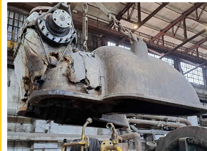
Капітальний ремонт обладнання енергоблоку ст.№4 ТЕЦ ПрАТ «Камет-Сталь», Метінвестхолдинг (турбіна АТ-25-2 ТМЗ, генератор ТГВ-25, насоси, конденсатор, підігрівачі та інше обладнання машинної зали, ремонт електродвигунів насосів та інших систем, заміна високовольтних вимикачів, ремонт іншого електричного обладнання та пристроїв КВП та А).
