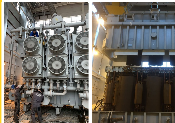
Ремонт трансформатора типу ТДЦ-430000/330-У1 ст.№ Т-4 Дністровської ГАЕС ПрАТ «Укргідроенерго» з метою визначення джерела газовиділення.
