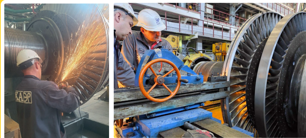
Аварійний ремонт ротора високого тиску турбіни К-1000/3000 потужністю 1000МВт бл. №2 Хмельницької АЕС НАЕК «Енергоатом».
