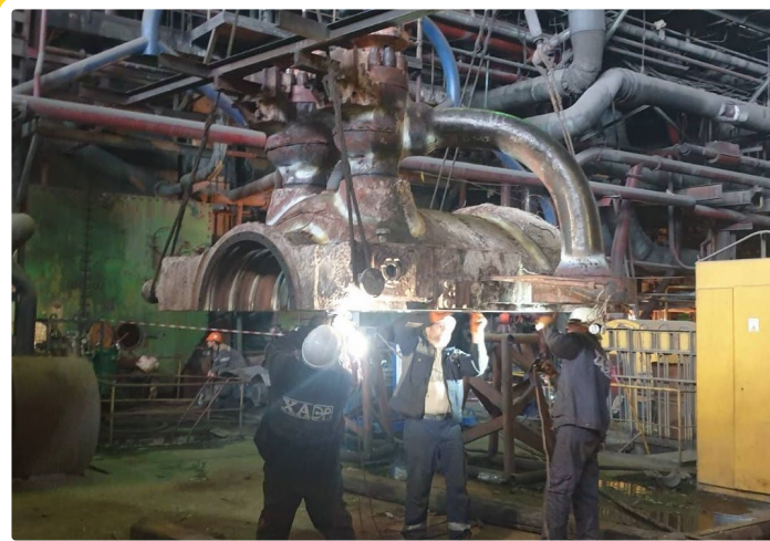
Ремонт турбіни К-200-130 енергоблоку ст. №9 та ремонт циліндра високого тиску і ремонт ротора середнього тиску із заміною пошкоджених лопаток та бандажа турбіни К-200-130 енергоблоку ст.№7 ДТЕК Бурштинська ТЕС Західенерго.
